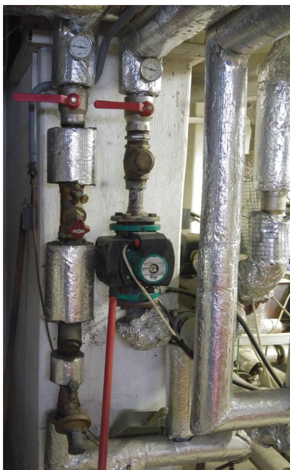
Obrázek 9 V levém obrázku větve pro ÚT, uprostřed a vpravo detail regulační a vyvažovací armatury.
