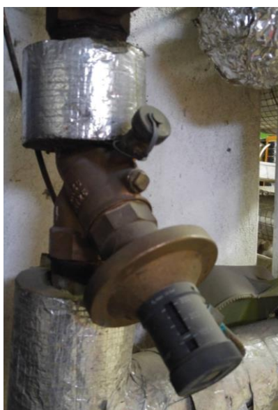
Obrázek 9 V levém obrázku větve pro ÚT, uprostřed a vpravo detail regulační a vyvažovací armatury.
